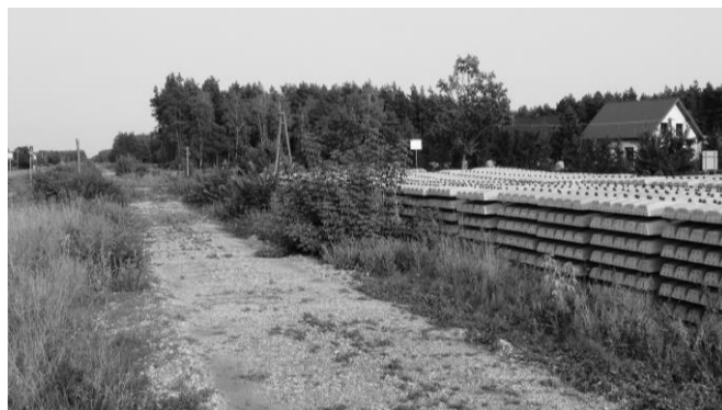
● Linia kolejowa Ostrołęka – Chorzele po przerwaniu prac: zdemontowany tor i zgromadzone materiały, połowa września 2020 r.
