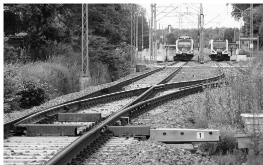
• Działająca od 2019 r. mijanka Bukowice Trzebnickie na jednotorowym ciągu Oleśnica – Milicz – Krotoszyn.
