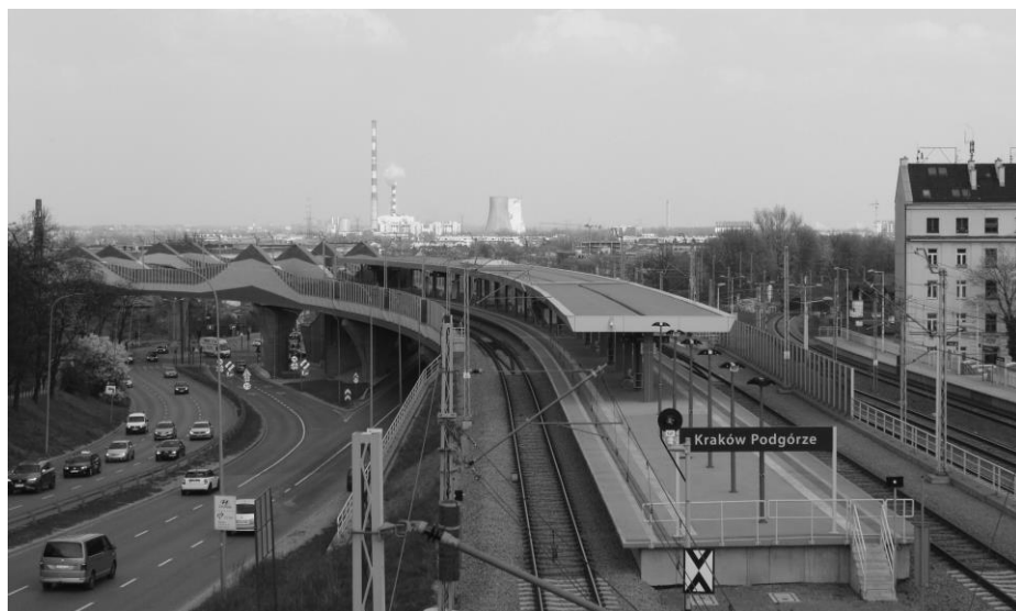
• Górujące nad miastem estakady łącznicy, która od 2017 r. umożliwi wyjazd z Krakowa Głównego w stronę Zakopanego bez zmiany kierunku na stacji Kraków Płaszów.
