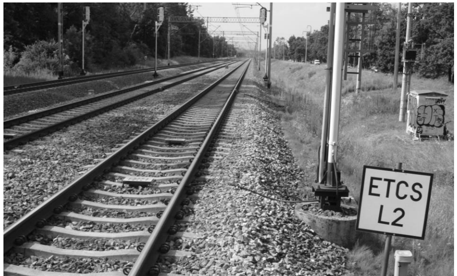
• Początek odcinka objętego systemem ETCS na linii Warszawa – Gdańsk. W torze widoczne balisy przekazujące informacje do urządzeń pokładowych w pociągach.
