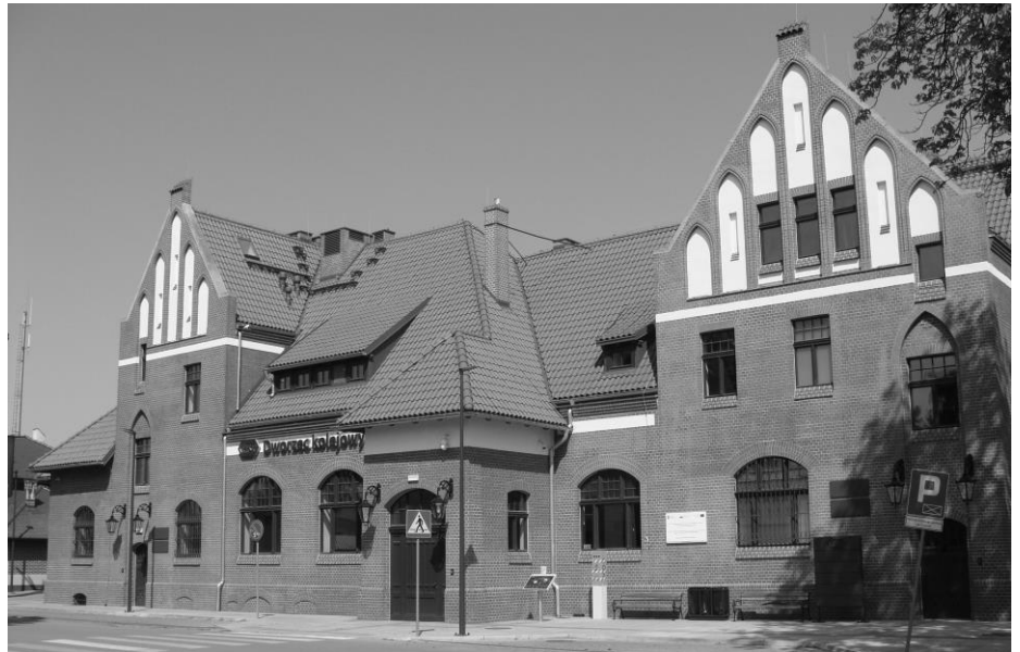
• Dworzec w Pszczółkach. Pieczolowicie odremontowany i kompletnie pusty.
