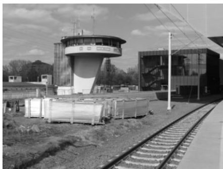
• Nastawnia na przebudowywanej stacji Warszawa Zachodnia.
