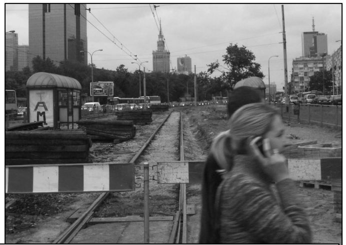
Remont torowiska tramwajowego w Al. Jerozolimskich w Warszawie.
