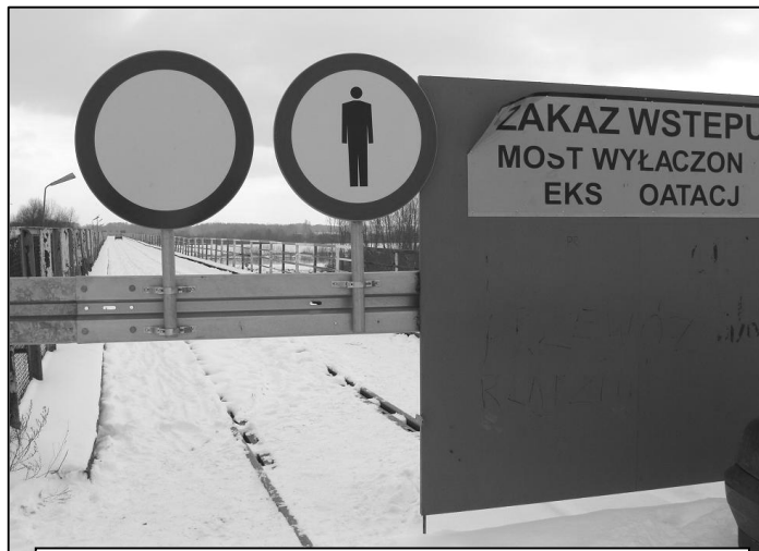
Most kolejowo-drogowy na Bugu w Małkini – od 1998 r. nieczynny dla pociągów, a od 2008 r. zamknięty dla samochodów i pieszych – wkrótce zostanie rozebrany. Za unijne pieniądze na jego miejscu powstanie nowa przeprawa. Ale już tylko dla samochodów. (Fot. KT)
