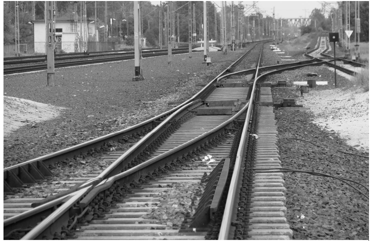
• Rozjazdy na 54 i 56 stacji Warszawa Rembertów, czyli wąskie gardło powstałe w wyniku modernizacji.
