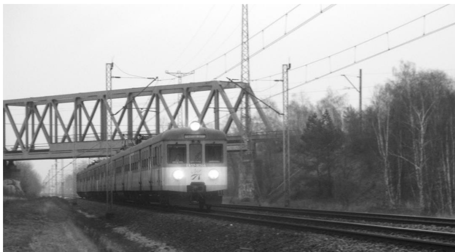
• Zmodernizowany odcinek magistrali E-20 w okolicach stacji Warszawa Rembertów. W nadchodzących latach ma rozpocząć się kolejna modernizacja tego odcinka.
