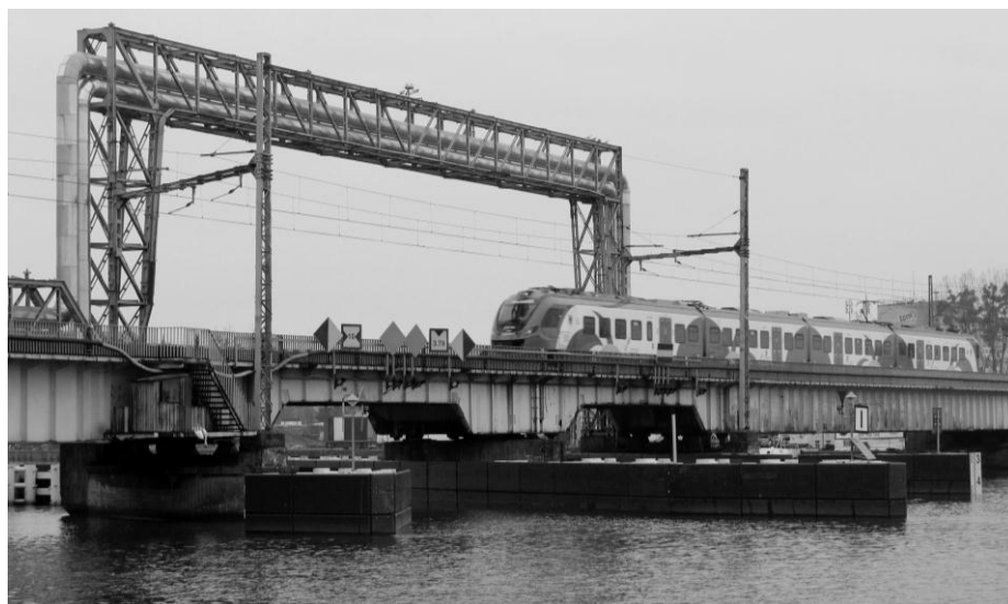
• Duża część mostów nie spełnia wymagań podpisanej przez Polskę konwencji AGN dotyczących prześwitu i rozpiętości na potrzeby żeglugi. Most kolejowy w Szczecinie.
