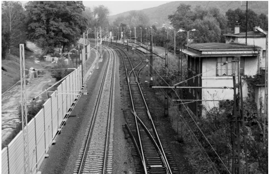
• Październik 2017 r., prowadzona w ramach modernizacji linii Kraków – Katowice przebudowa stacji Rudawa w przystanek: widoczne znikanie układu torowego umożliwiającego przepuszczanie szybszych pociągów przez wolniejsze składy.
