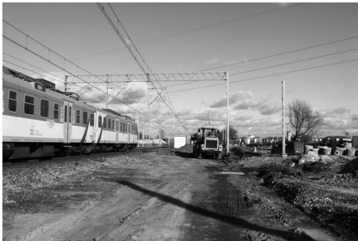
• Budowa przystanku Parzniew między Pruszkowem a Brwinowem.
