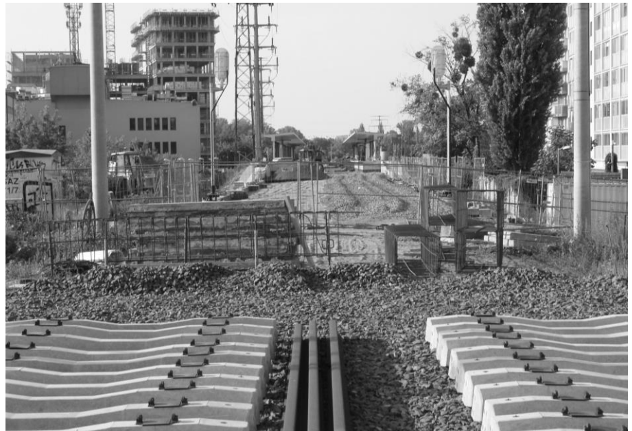
• Modernizacja warszawskiej linii obwodowej miała zakończyć się w marcu 2018 r. Stan prac w drugiej połowie czerwca 2018 r., odcinek Warszawa Młynów – Warszawa Koło.
