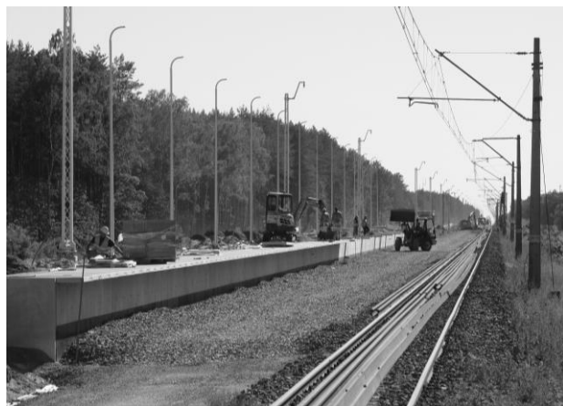
● Budowa nowych peronów na od lat nieużywanym przystanku Zaręby Kościelne na magistrali Warszawa – Białystok.
