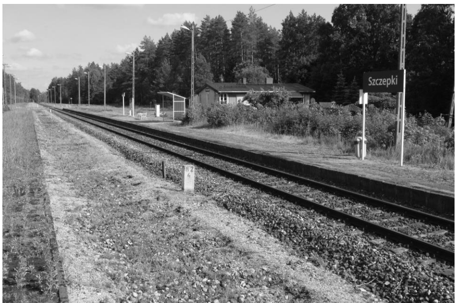
• Ślad po torze dodatkowym na zlikwidowanej mijance Szczepki na linii Sokółka – Suwałki.
