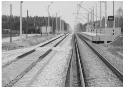
● Modernizowana linia z Warszawy do Radomia. Rejon przystanku Krężel.
