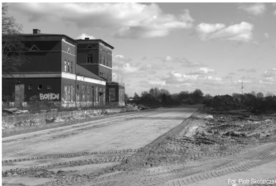
• Nowy przebieg drogi krajowej 26 przez Myślibórz został wytyczony śladem torów: budowa drogi przy budynku myśliborskiego dworca kolejowego. Kwiecień 2020 r.
