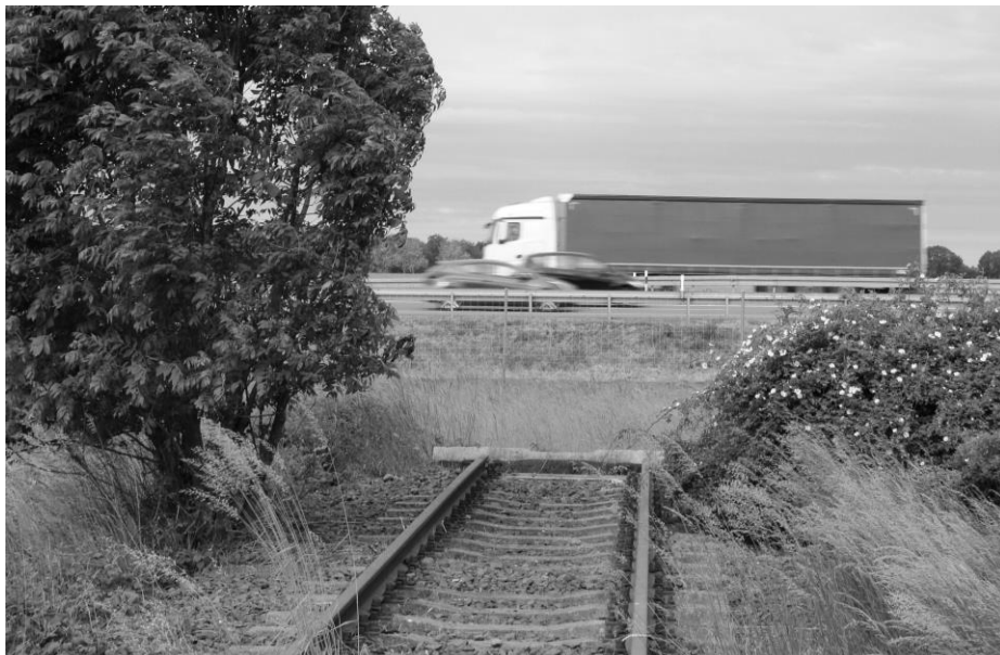
• Linia kolejowa Bojanowo – Góra w miejscu przecięcia przez drogę ekspresową S5.
