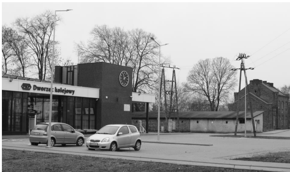
● Przystanek kolejowy Dębe Wielkie na linii Warszawa – Siedlce: innowacyjny dworzec systemowy (typu B) i na dalszym planie zamknięty zabytkowy budynek dworcowy.
