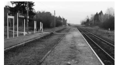
• Dawniej mijanka, a dziś przystanek Gozdowo na linii Płock – Sierpc (z lewej widoczny ślad po torze mijankowym).
