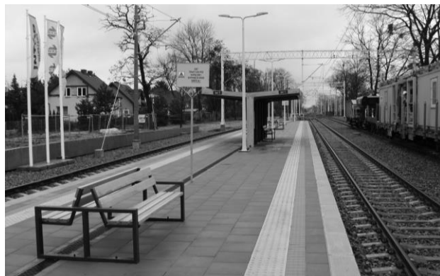
● Przebudowana stacja Grodzisk Mazowiecki Radońska.
