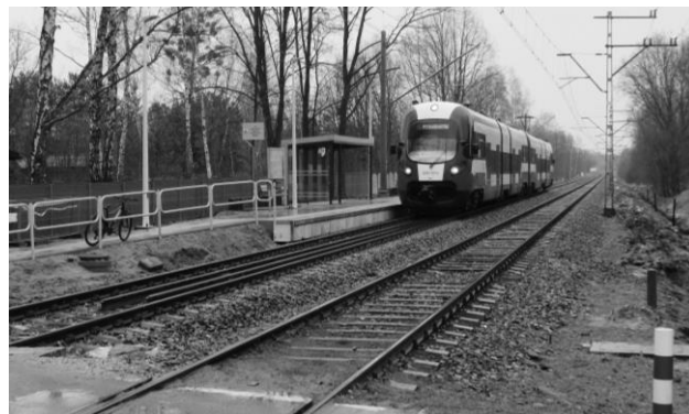
● Pociąg WKD na nowo wybudowanym drugim torze między Podkową Leśną a Grodziskiem Mazowieckim. Przystanek Brzózki.
