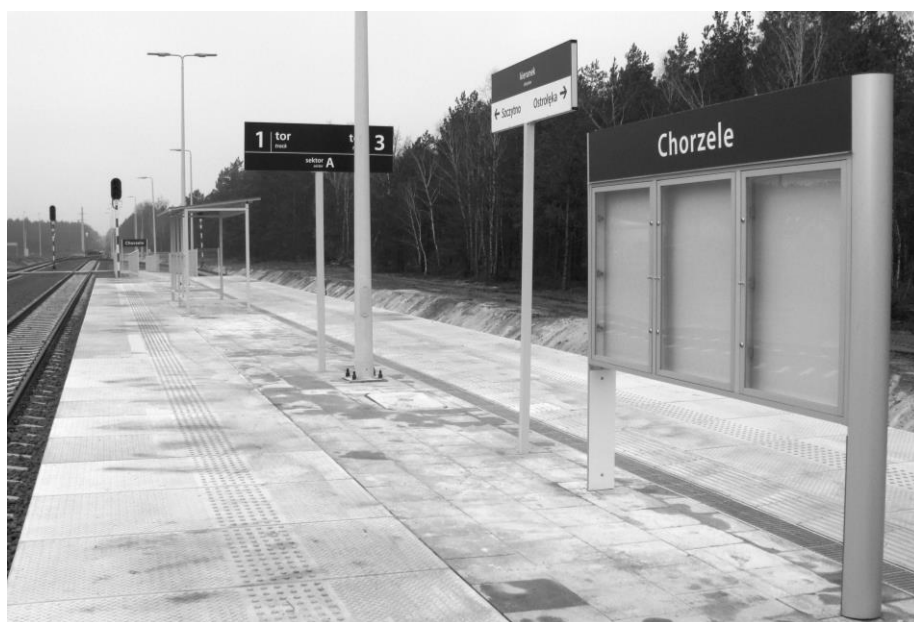
• Przywrócona do życia i zmodernizowana stacja Chorzele czeka na wznowienie połączeń.
