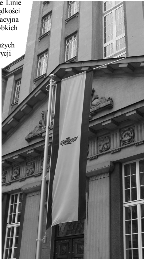
• W centrali spółki PKP Polskie Linie Kolejowe powstało Centrum Kolei Dużych Prędkości.
