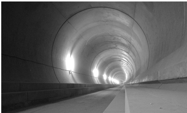
• Budowa tunelu Gottharda pod szwajcarskimi Alpami (fot. AlpTransit)
