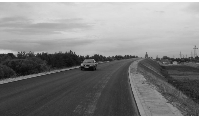
• Modernizowana droga wojewódzka 627 została w okolicach Małkini wytyczona po śladzie linii kolejowej Siedlce - Ostrołęka.
