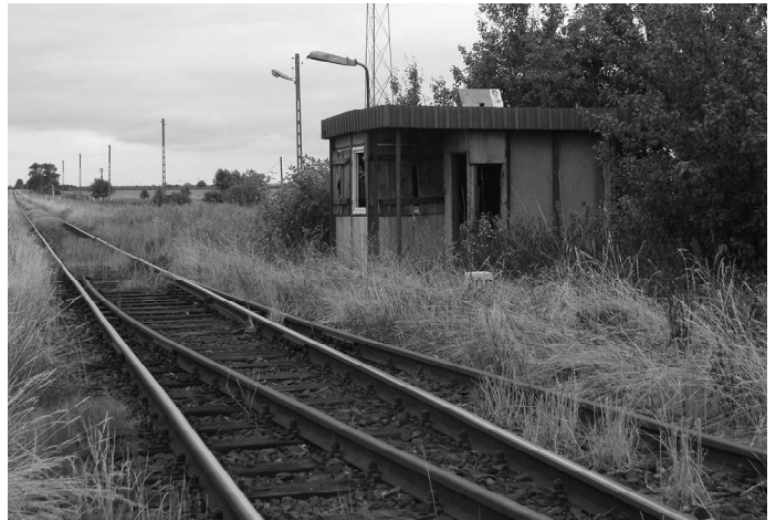
• Stacja Suchozębry na linii kolejowej Siedlce - Sokołów Podlaski. Czy wkrótce wkroczą tu ekipy demontujące tory?
