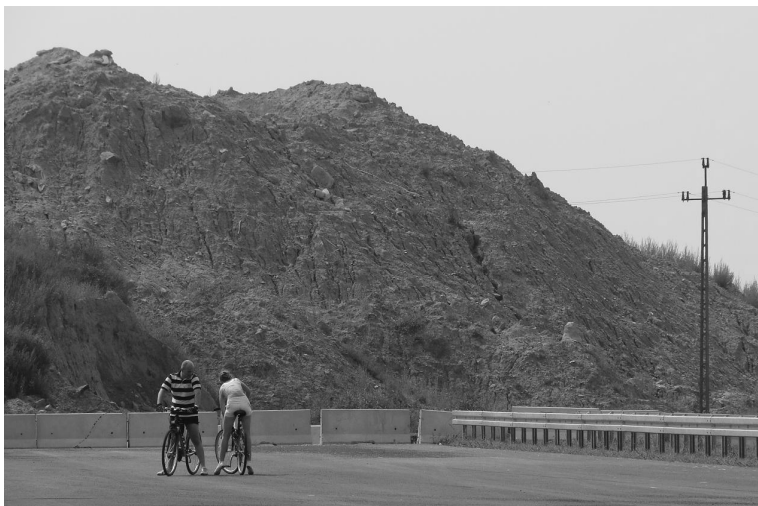
• Budowa węzła drogowego w Konotopie położonej między Ożarowem Mazowieckim i Piastowem. Tędy autostrada A2 wjechać ma do Warszawy.
