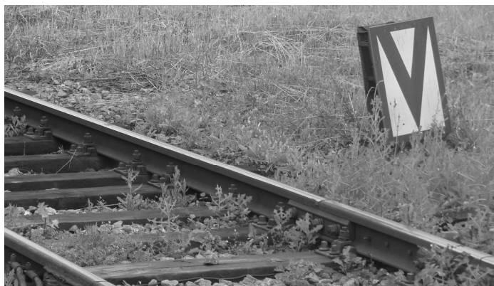
• W sytuacji fatalnego stanu istniejącej sieci kolejowej 55 mln zł wydano na kolej dużych prędkości, której nie będzie
