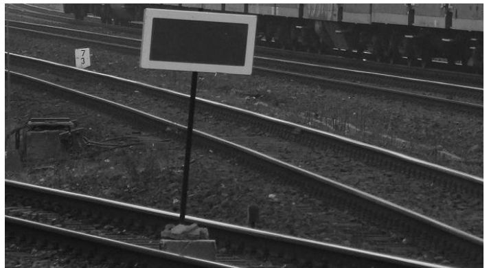
• Z końcem roku 2 tys. km linii kolejowych zostanie zamkniętych.
