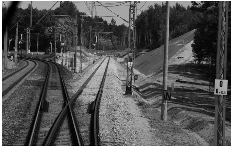
• Zjazd z magistrali nadodrzańskiej Szczecin - Wrocław na nową linię kolejową, dzięki której udało się osiągnąć najkrótszy w historii czas przejazdu z Zielonej Góry do Poznania. (fot. lubuskie.pl)
