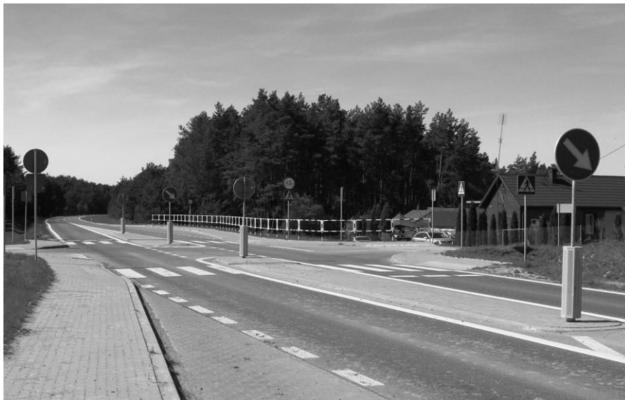
• Nowy przebieg drogi wojewódzkiej 627 od Kosowa Lackiego do Małkini Górnej wytyczono po nieczynnym odcinku linii kolejowej Siedlce – Ostrołęka, bezpowrotnie uniemożliwiając odtworzenie tego połączenia. Miejsce dawnego przystanku kolejowego Wólka-Okrąglik.
