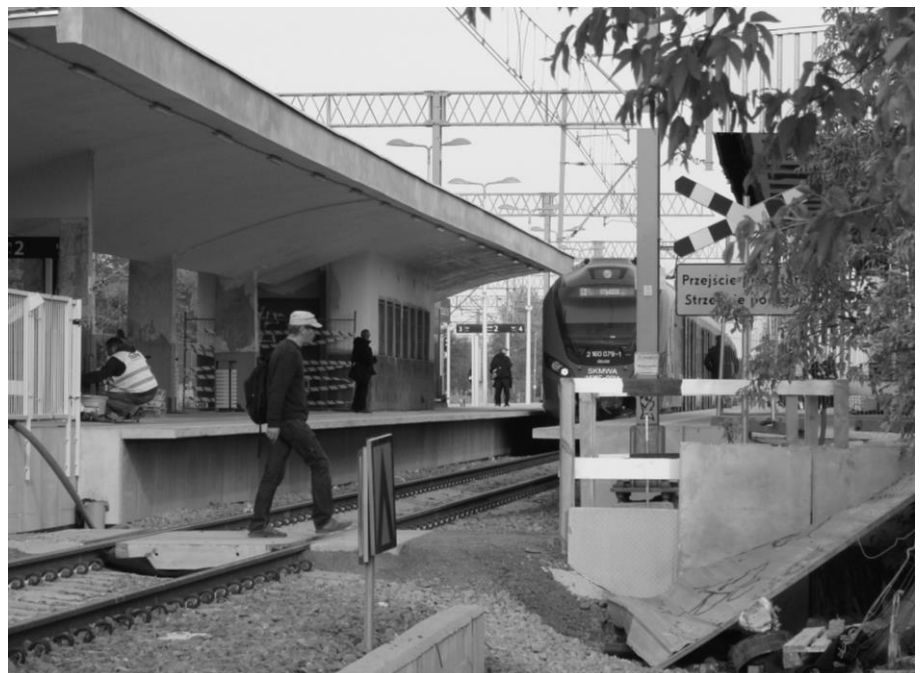
• Zamknięte przejścia podziemne, roboty na peronach, ograniczenia prędkości. Tak wygląda sytuacja na linii Warszawa – Grodzisk Mazowiecki po przywróceniu kursowania pociągów.
