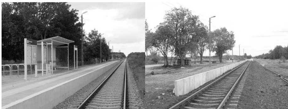
• Na linii Nasielsk – Sierpc poprawia się standard infrastruktury dla pasażerów. Wyremontowany przystanek Wkra i przystanek Dalanówek w trakcie renowacji.
