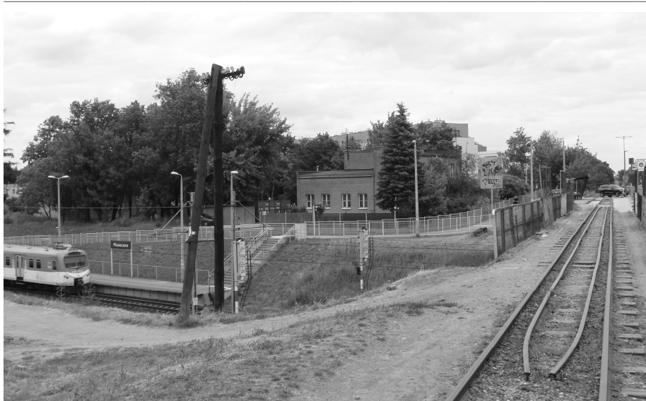
• Wiadukt piaseczyńsko-grójeckiej kolei wąskotorowej nad stacją Piaseczno na linii normalnotorowej Warszawa – Radom.
