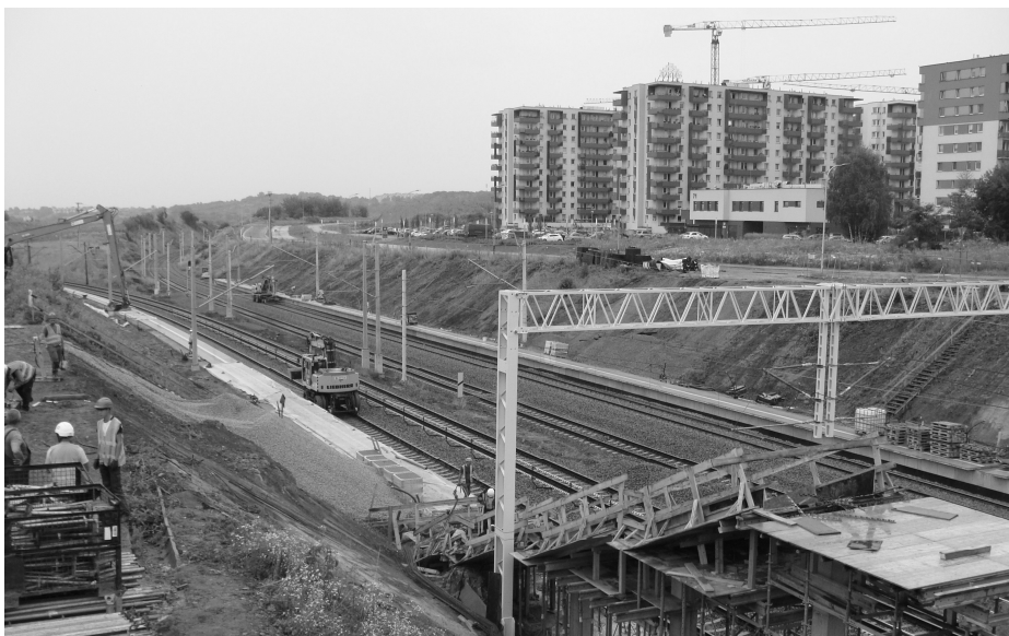
• Przystanek Kraków Piastów podczas budowy w sierpniu 2024 r. Leżący na północnym skraju miasta przystanek został otwarty w grudniu 2024 r. – pociągami do centrum Krakowa jedzie się stąd dziewięć minut.
