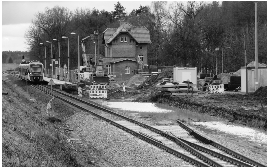
• Prace przy odbudowie mijanki Roszkowo Wągrowieckie na odcinku Wągrowiec – Stawa Wielkopolska, którego przepustowość uległa całkowitemu wyczerpaniu.
